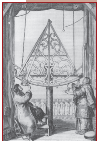
Figura 3.3. Sextante de Johannes Hevelius (1611-1687), astrônomo do século 17. Os sextantes também existiam em modelos menores, mais práticos para medições em alto mar.
